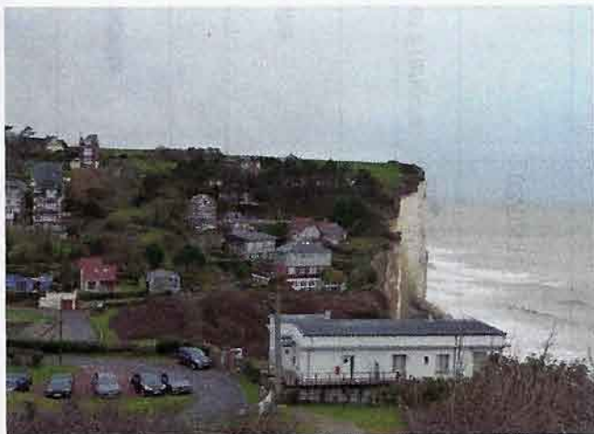
L'étude sur l'assainissement concernera les douze maisons situées dans la zone rouge.
