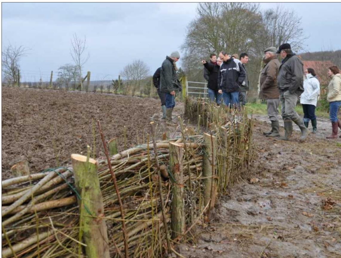
Une fascine, avec des saules, a été placée pour limiter l'érosion, à cet endroit sujet à des coulées de boue.
