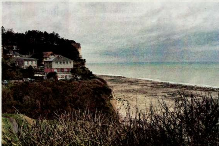
La zone rouge du PPR de 2015 englobe une bande de près de 70 mètres depuis la falaise.
