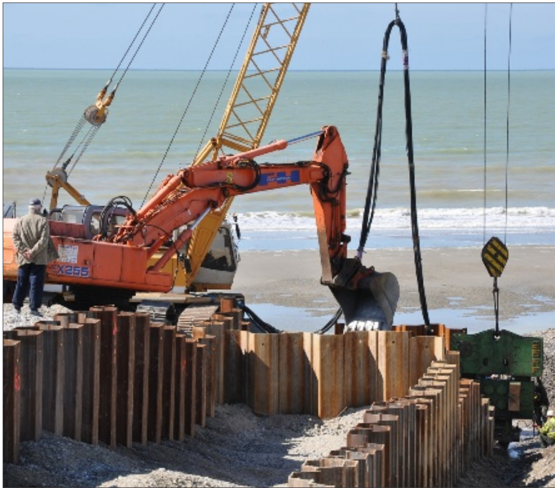
La construction de 24 épis supplémentaires à Cayeux-sur-Mer devrait être terminée à la fin de l'année.
