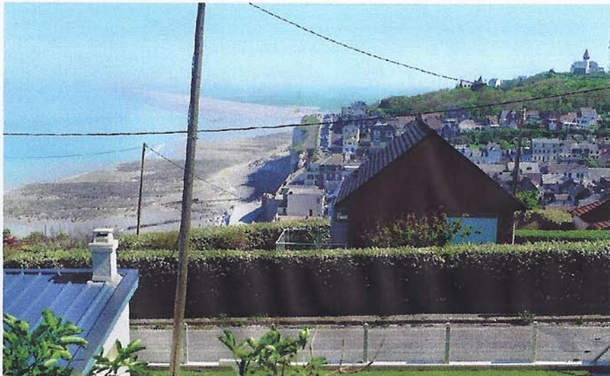
Un plan de prévention des risques littoraux Falaises picardes avait été mis en oeuvre à Ault, définissant notamment une zone rouge, une bande inconstructible de 70 m.
