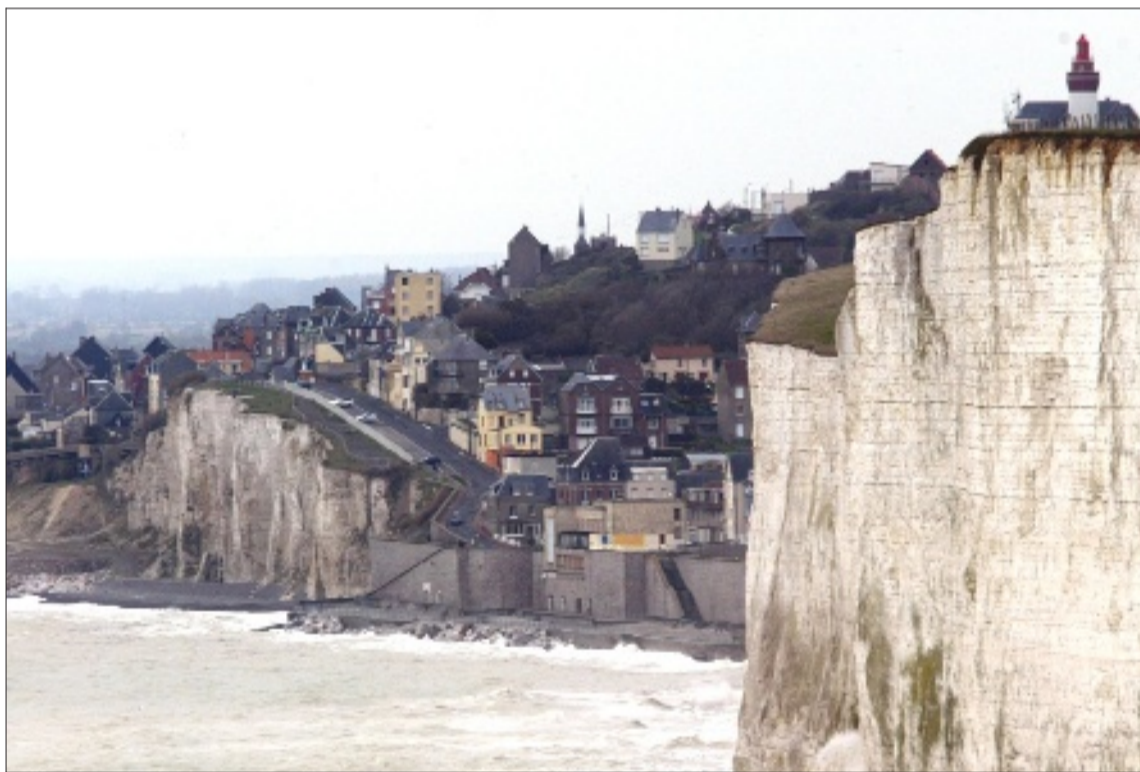
L'aménagement de la zone du Moulinet, à Ault, doit permettre un repli car l'érosion des falaises menace des habitations.
