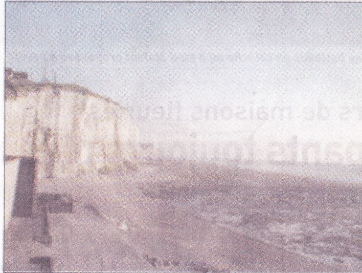
"On rechigne à mettre de l'enrochement entre Ault et Onival" déplore le président de Ault environnement.
