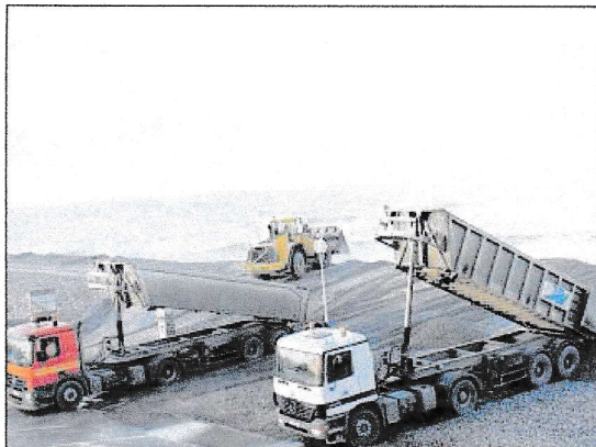
La construction, l'entretien de digues et le rechargement en galets de Cayeux et de la zone des bas-champs ont coûté 70 millions d'euros pour 7 km de côte.
