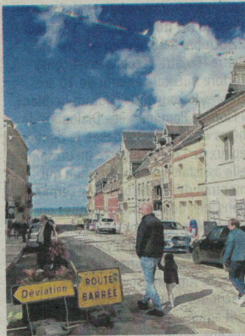
Le réseau d'assainissement dans la Grande rue a dû être de nouveau remplacé.
