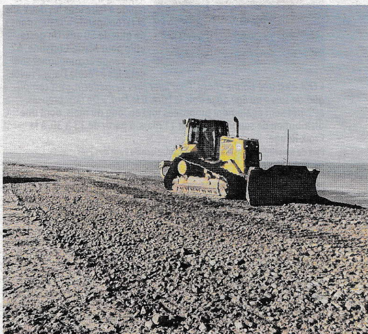
Ce rechargement massif de galets vient en plus des campagnes régulières. Il a été rendu nécessaire par les tempêtes Eunice et Franklin.
