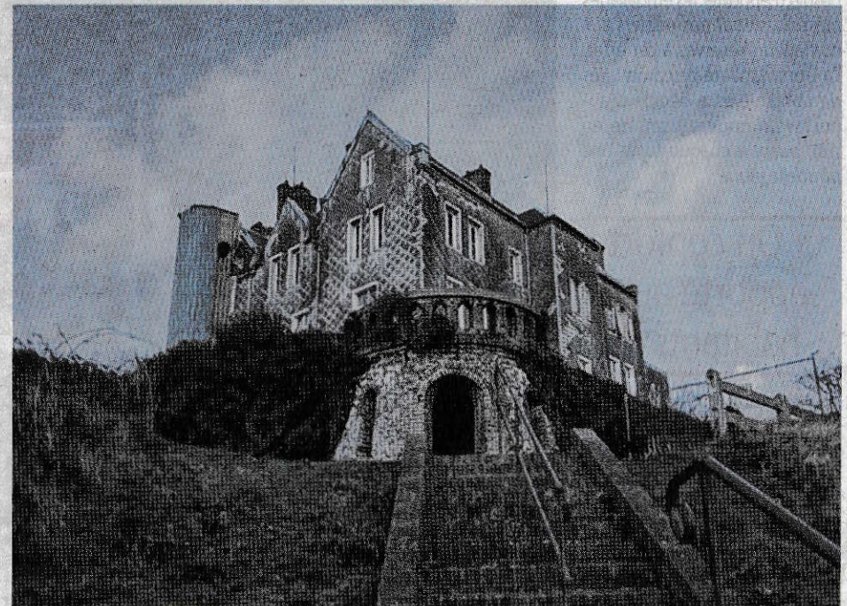
Le château va être réhabilité à l'identique et sera accompagné de nombreux logements. Les travaux vont commencer dans plus d'un an et dureront de 18 mois à 2 ans.
