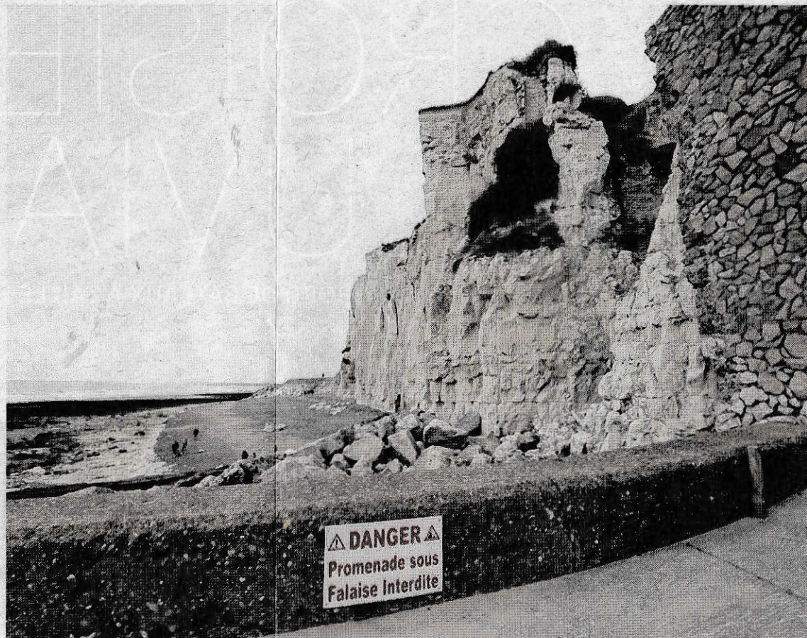
À Ault, la falaise est grignotée là où il n'y a pas de digue. (Photo d'archives FRED HASLIN)
