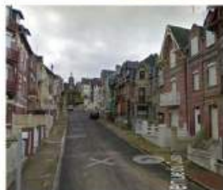
Exemple frontage délaissé Aut
