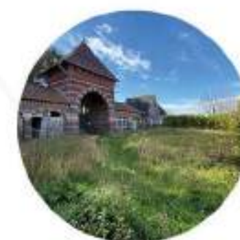
8 Place de la Ferme du Moulinet
