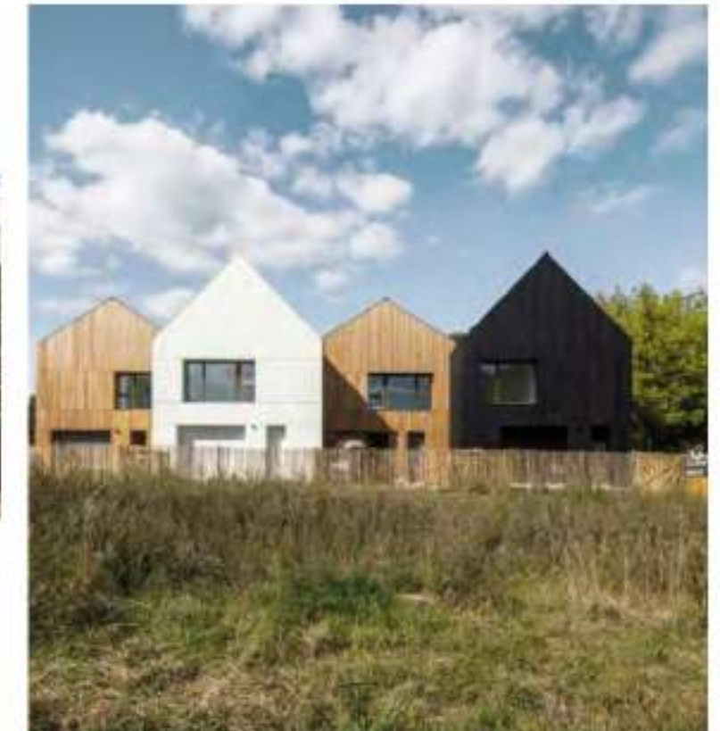
Logements Nogent le Rotrou - NZI
