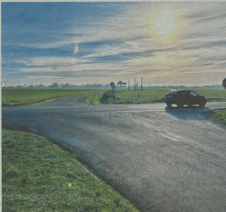
La prairie inondable va être créée à proximité de la route d'Ault en direction de Saint-Quentin-Lamotte.
