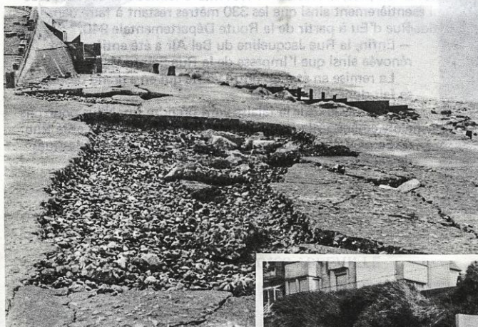
Les dégâts causés à l'Esplanade de la Plage d'Onival
