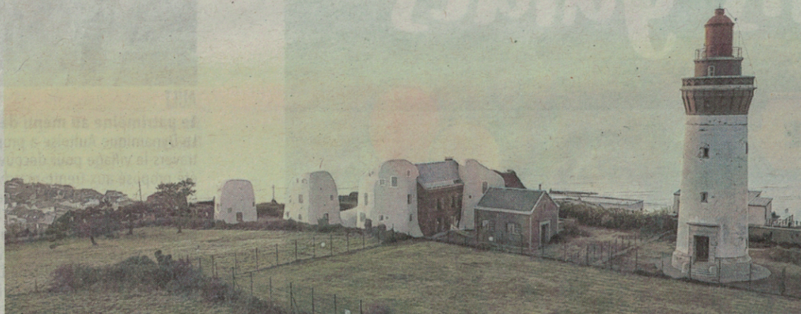
La future Maison du Phare telle qu'elle a été imaginée avec ses extensions construites en craie. (Document agence Architectures possibles)
