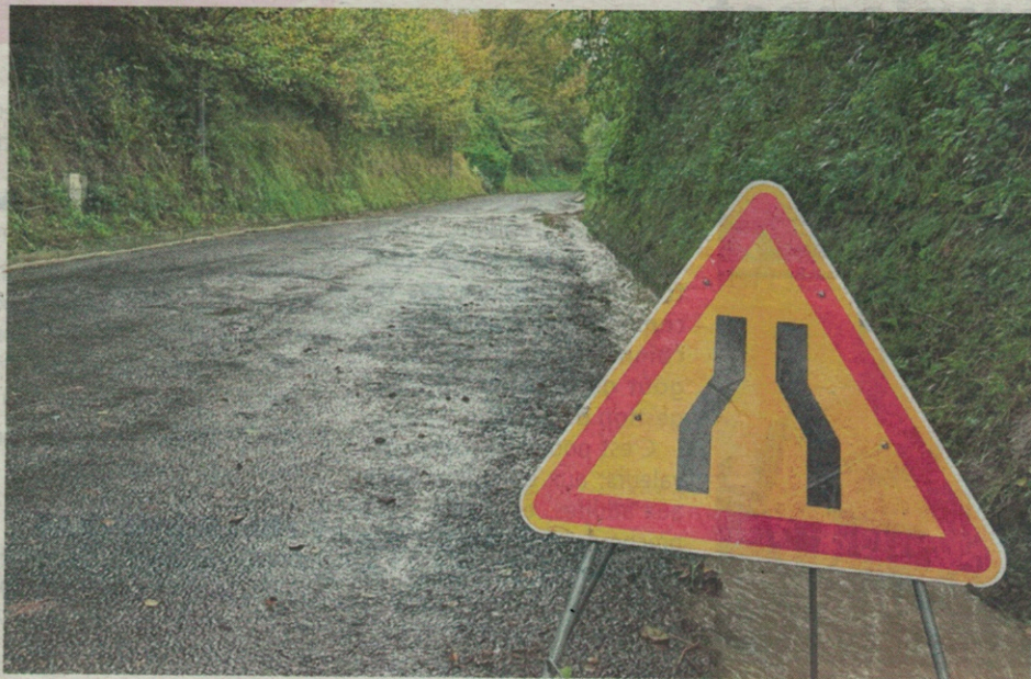
La rue d'Eu va faire peau neuve à Ault. Un nouvel enrobé va être déposé et des bordures vont être mises en place. Augustin Thibouw
