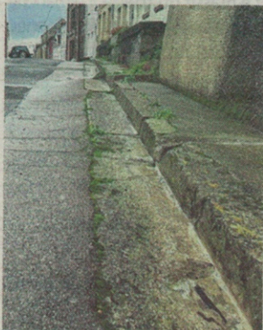
Le trottoir entre les numéros 51 et 53 de la rue des fonds bénits va être refait.
