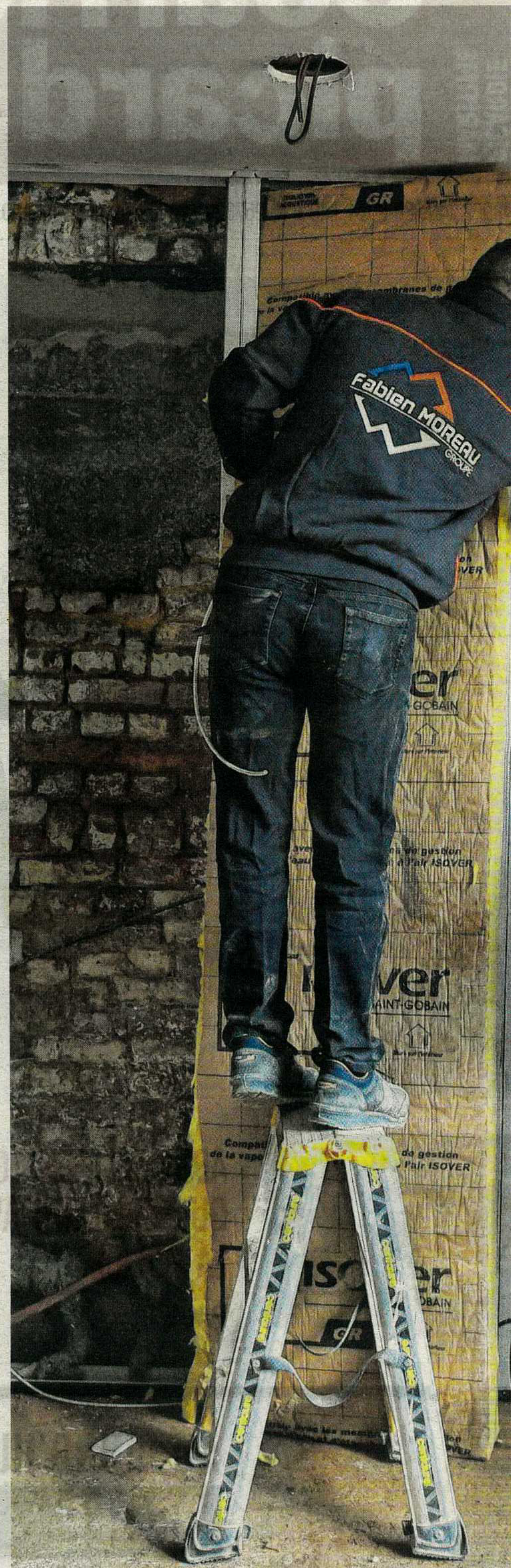
Les travaux de rénovation énergétique d'ampleur seront favorisés. FLORENT MOREAU
