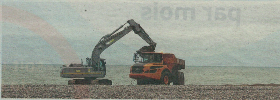
Des travaux de redistribution des galets sur la plage.
