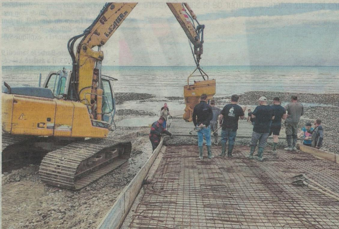
Les épis sont contrôlés et renouvelés selon leur degré d'usure et donc d'urgence, comme ici lors d'un chantier de réfection du dessus en béton de plusieurs épis, en 2022. CPicard
