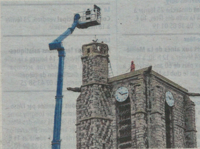
Les compagnons sont épaulés par deux cordistes sur le toit du beffroi. (Photo Xavier Togni)
