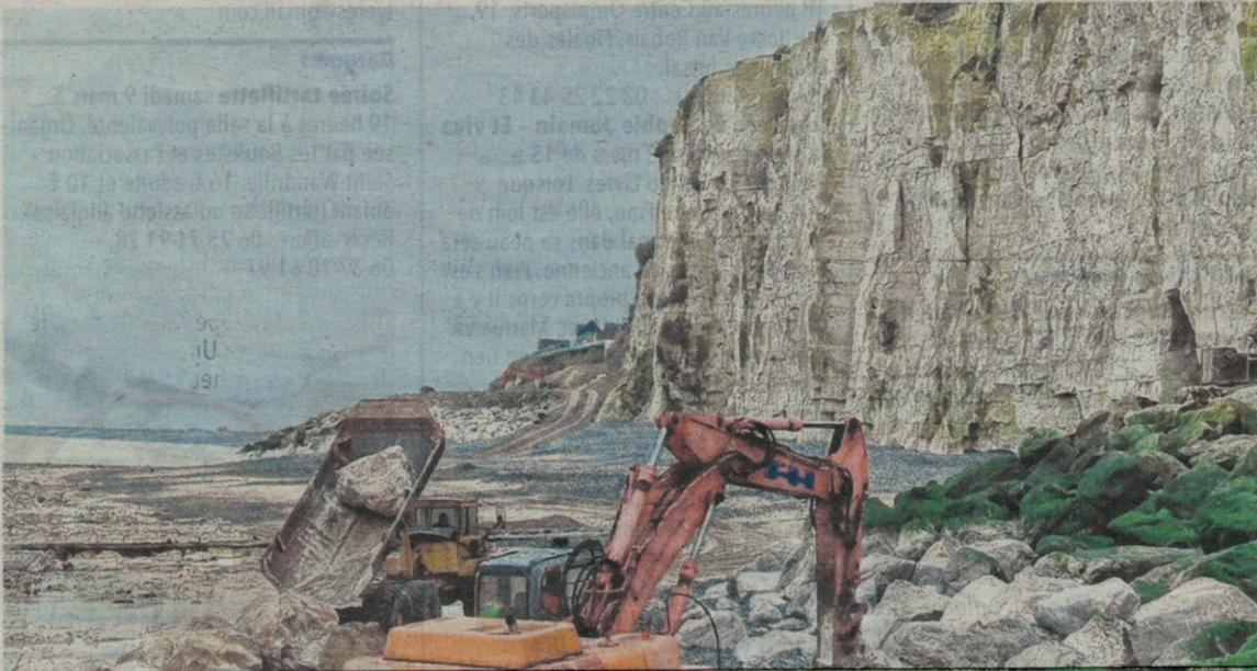
Les engins de chantier s'activent au pied de l'esplanade d'Ault pour renforcer l'enrochement. (Photo Xavier Togni)
