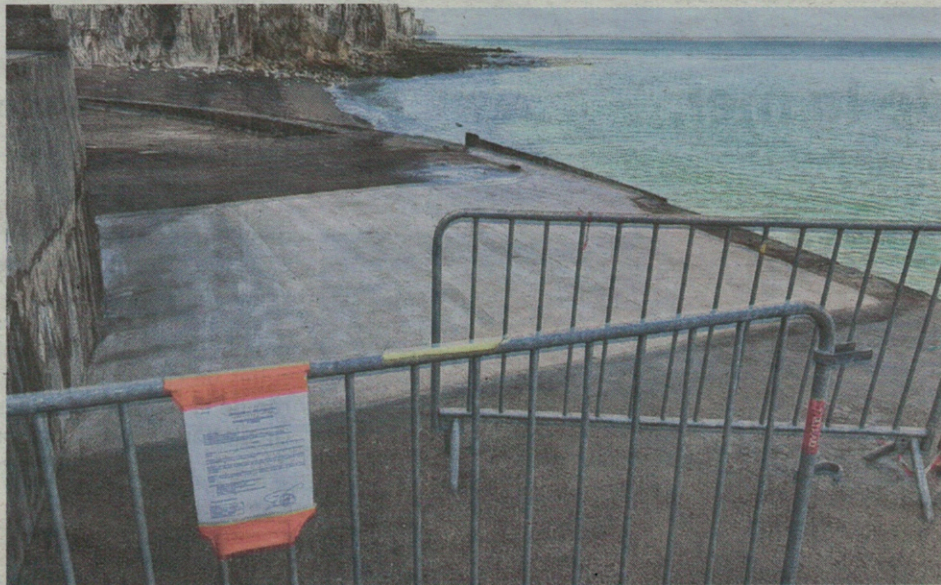
Après l'effondrement, l'esplanade de la plage d'Ault a été réparée. Augustin Thibouw
