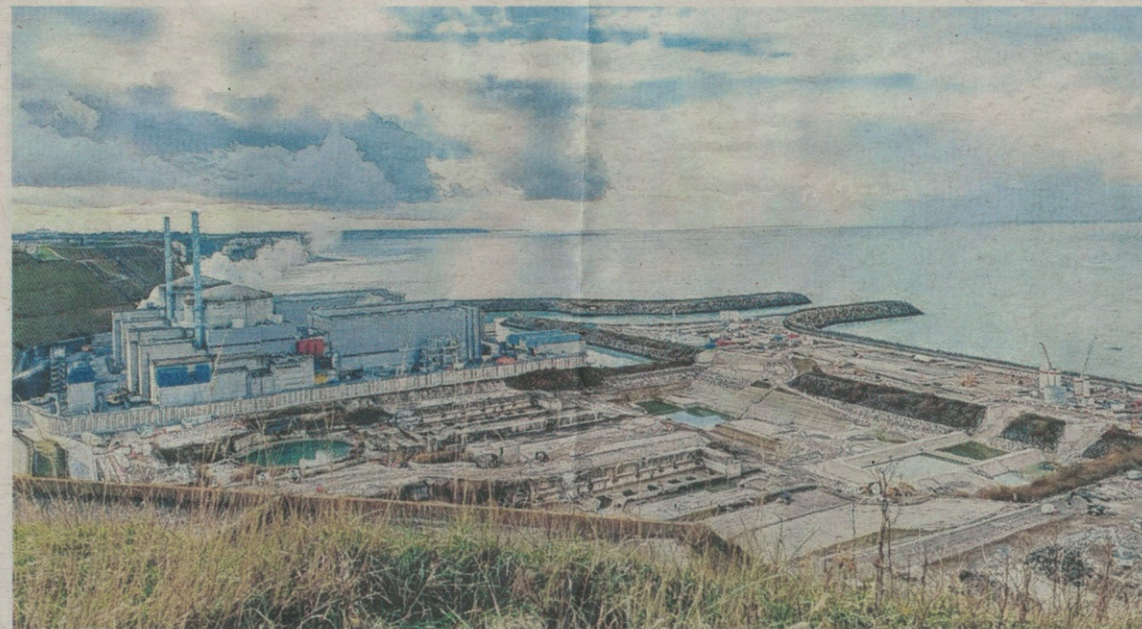
Pour les médias Médiapart et Reporterre, le béton utilisé pour la construction du futur EPR2 à Penly n'est pas aux normes, ce que dément EDF. (Photo DR)
