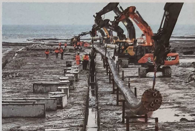
La pose des fourreaux sur les 500 premiers mètres de l'estran a été réalisée à l'aide de huit pelleuses. Une opération de précision. Arnaud Poirier
