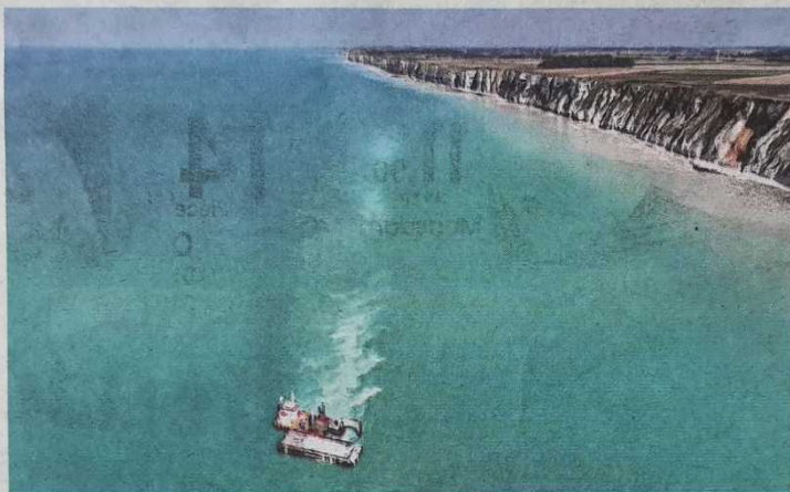
Deux tranchées ont également été creusées en mer. Arnaud Poirier
