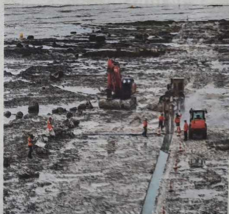
À marée basse, deux tranchées ont été creusées sur l'estran. Arnaud Poirier
