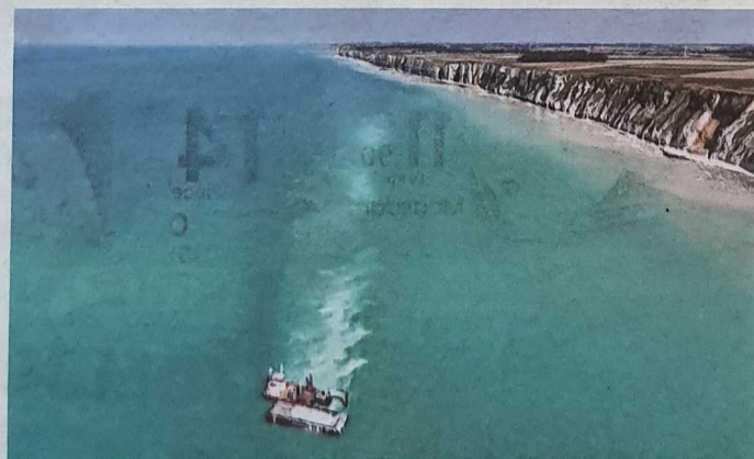
Deux tranchées ont également été creusées en mer. Arnaud Poirier
