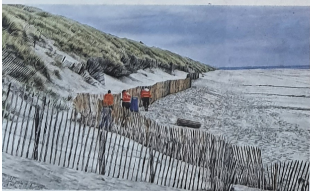
À Quend, les agents des services techniques installent des ganivelles, pour la saison. Leur efficacité pour retenir le sable est contestable, mais elles empêchent les promeneurs de grimper dans les dunes, ce qui accentuerait leur dégradation.
