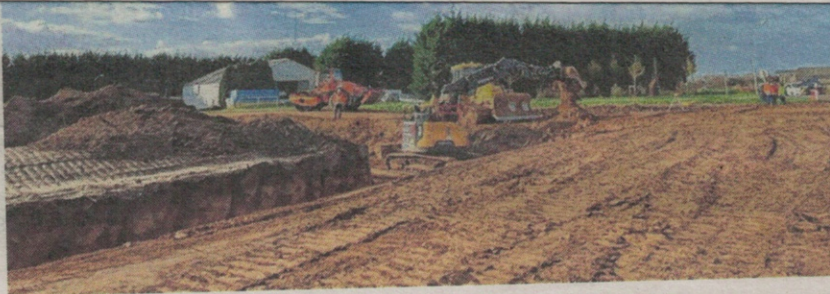
Les engins de chantier façonnent une prairie inondable sur les hauteurs d'Ault, au bord de la D940, à l'endroit même où se retrouvent les eaux du plateau en cas de fortes pluies.
