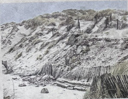
À Quend, le muret en béton et les ganivelles ont été arrachés sur la dune. Emmanuelle Lebon
