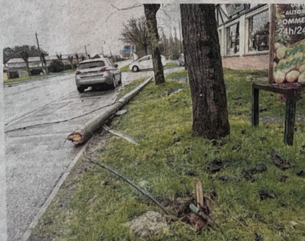
Un pylône électrique tombé sur la chaussée à Nouvion. Jean Ponchon
