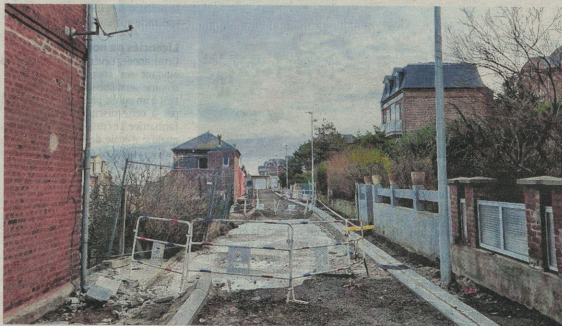
La rue de la Terrasse, à Onival, est réhabilitée, notamment pour mieux gérer l'écoulement des eaux pluviales.
