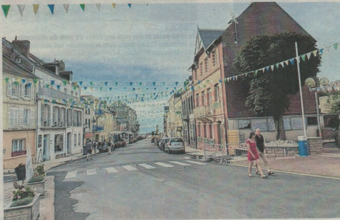
La dernière phase du chantier d'aménagement est lancée dans le centre-bourg d'Ault. Mais le réseau d'assainissement doit être de nouveau refait.
