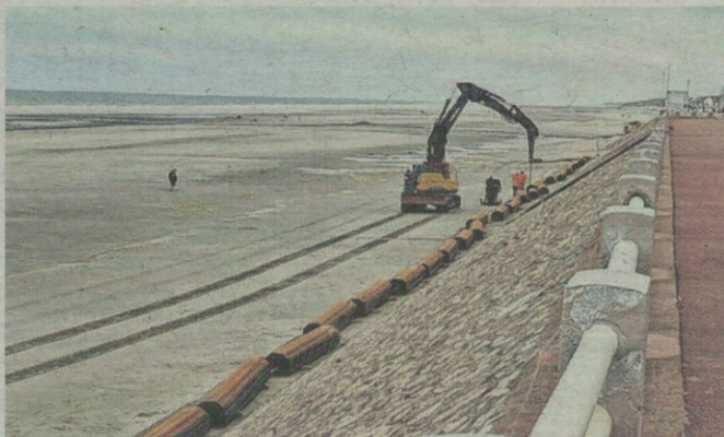
Des palplanches seront installées devant le Perré au sud du boulevard maritime de Quend-Plage.
